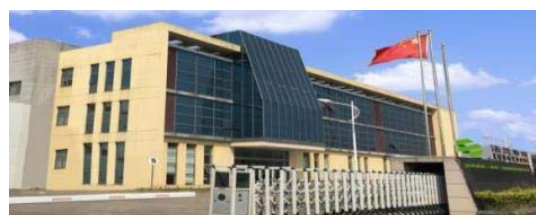
Завод по производству конструкций
